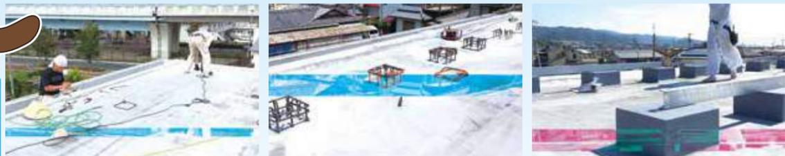
太陽光パネルを設置する部分を、補強及び架台を設置しました。
